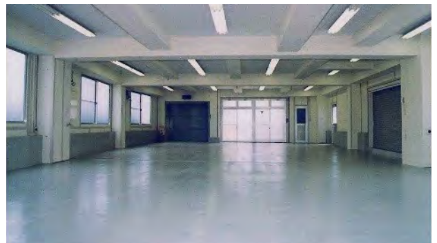
増田自動車修理工場内装工事
