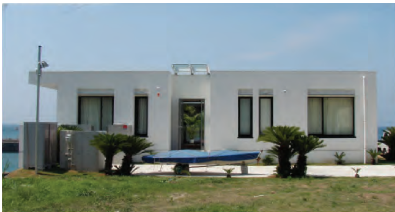
(仮称) 箕浦邸岩井新築工事
