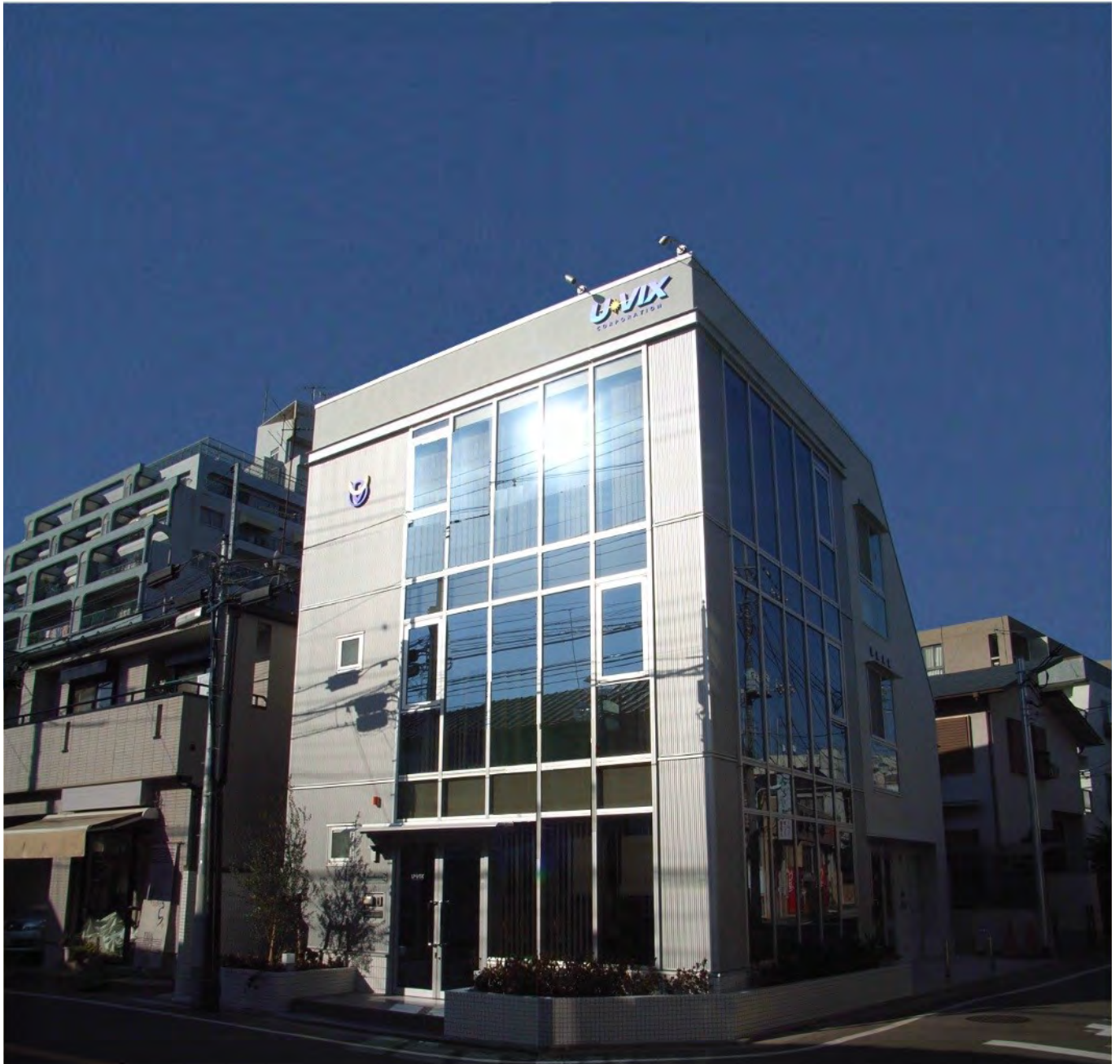
(仮称) Uvix ビル新築工事
