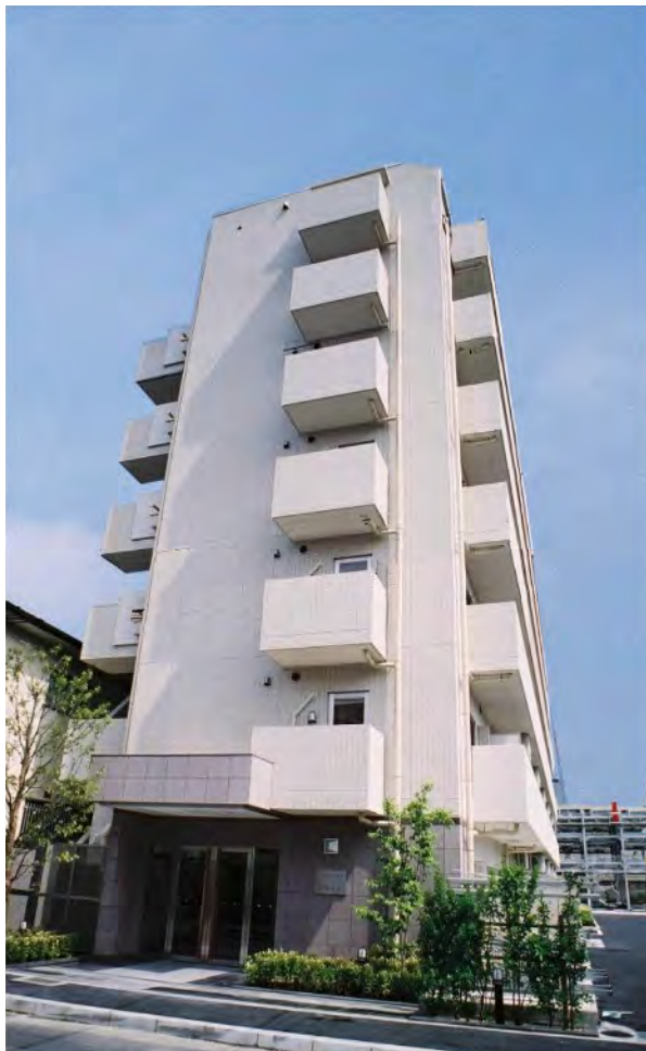
(仮称) 下新城 1 丁目マンション 新築工事
