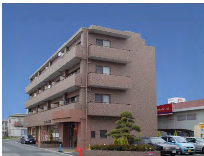
(仮称) 狩野ビル新築工事
