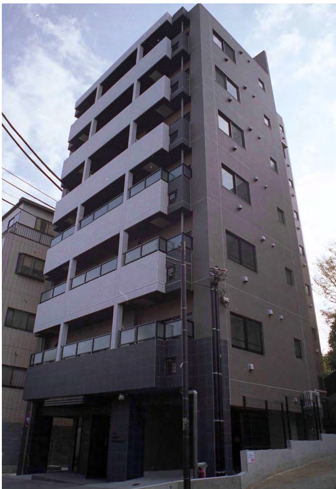
(仮称) 板橋 3 丁目マンション新築工事
