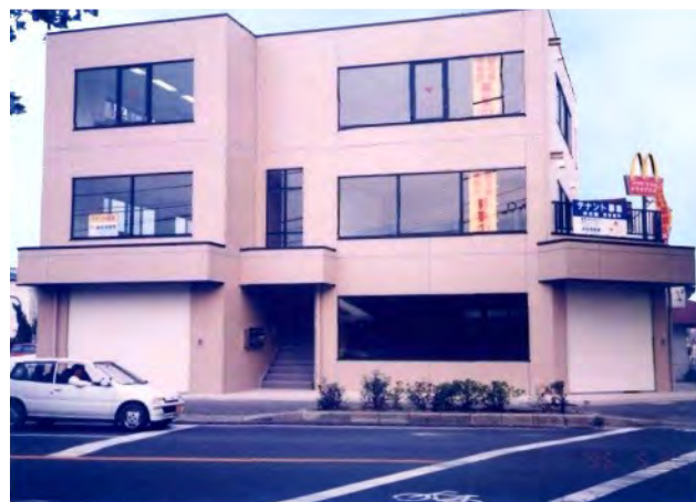
(仮称) 赤澤商事ビル改修工事
