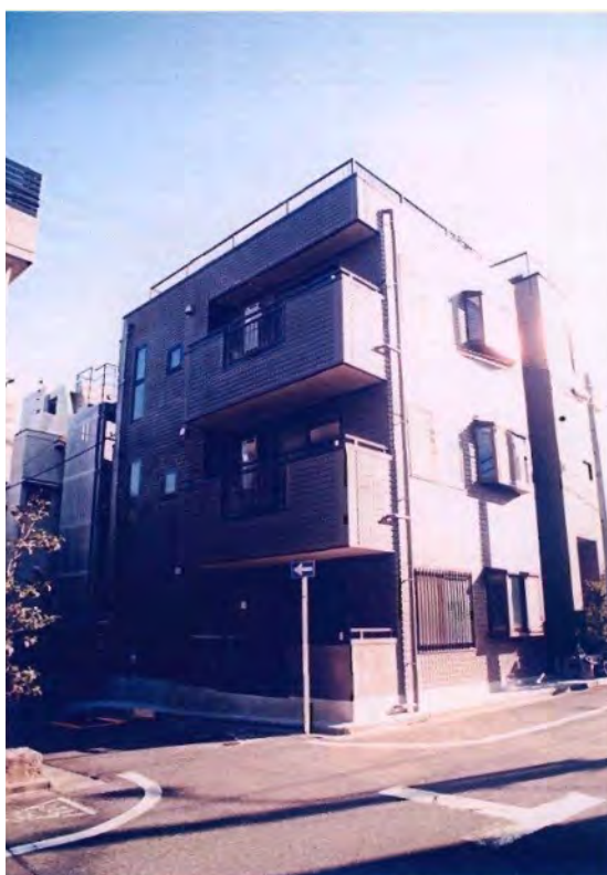
(仮称) 水野ビル新築工事
