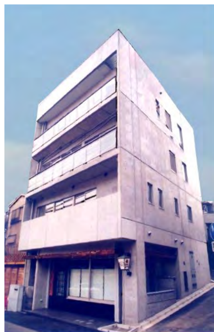
(仮称) 五味邸新築工事
