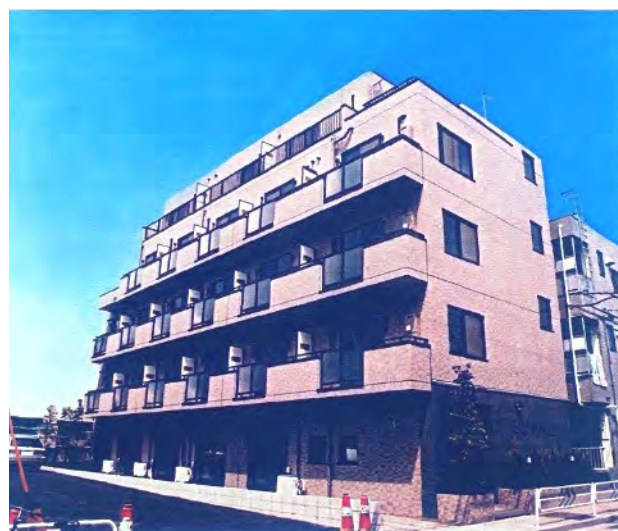
(仮称) アクティオ葛西寮新築工事
