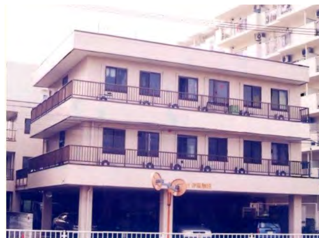
(仮称) (有)伊藤舗装社員寮新築工事
