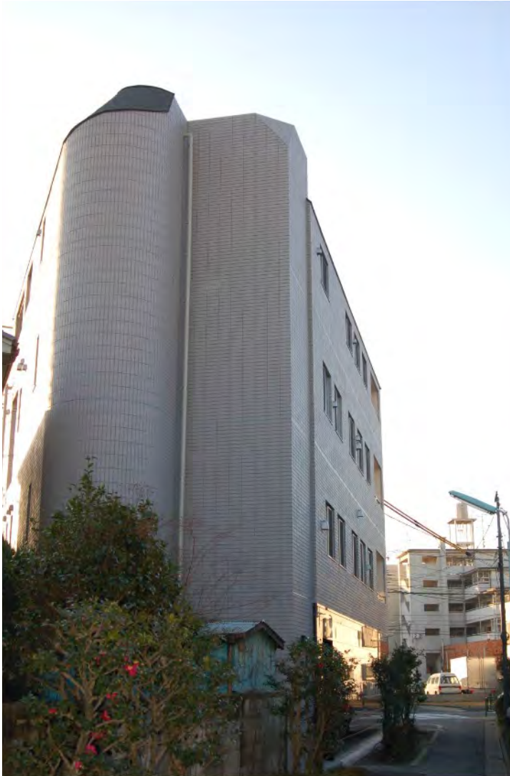
(仮称) 新里開発(株)ビル新築工事
